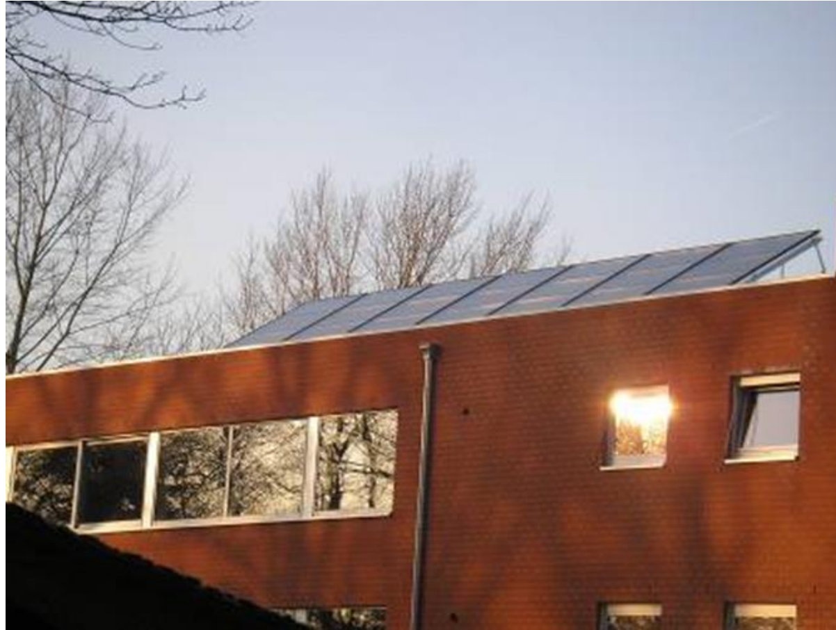
GEOTABS zorgcentrum Moorslede
